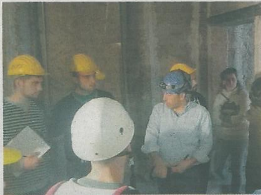
Una fase della visita guidata in uno dei cantieri
